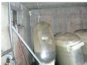
Öltank ohne Auftriebsicherung
