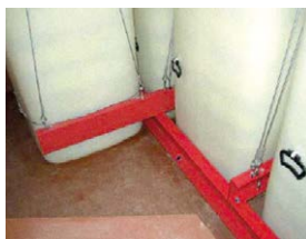
Öltank mit Auftriebsicherung
