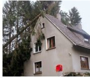
Ein durch Sturm entwurzelter Baum beschädigt das Dach
