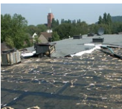
Abgerissene Wärmedämmung an einem Flachdach
