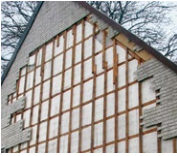
Abgerissene Fassadenbekleidung an einer Hauswand
