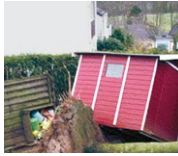
Auch Außenanlagen sind von Sturmschäden betroffen
